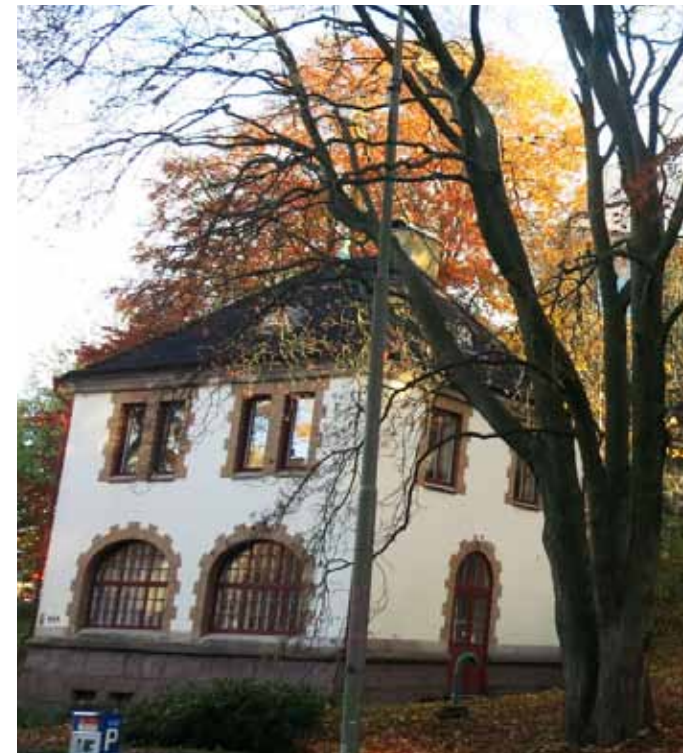
Figur 5. Pumphuset och Fjäderborgen, den f.d. vattenreservoaren syns i bakgrunden, ingår i bevarandeområde Landala 9:2.
