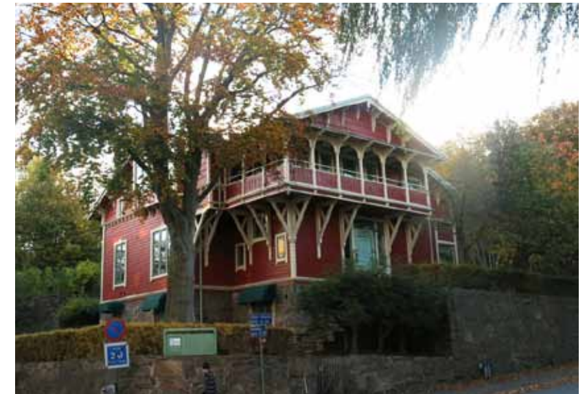
Figur 59. Villan på Föreningsgatan 25 är ett exempel på fornnordisk villaarkitektur, med omsorgsfullt och detaljrikt utformade fasader.
