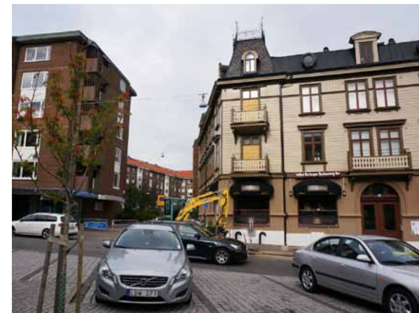
Figur 44. Vy från Landala Torg mot planområdet. Här möts landshövdingehus och modern bebyggelse. Byggnaderna har skilda uttryck men harmoniserar i skala.
