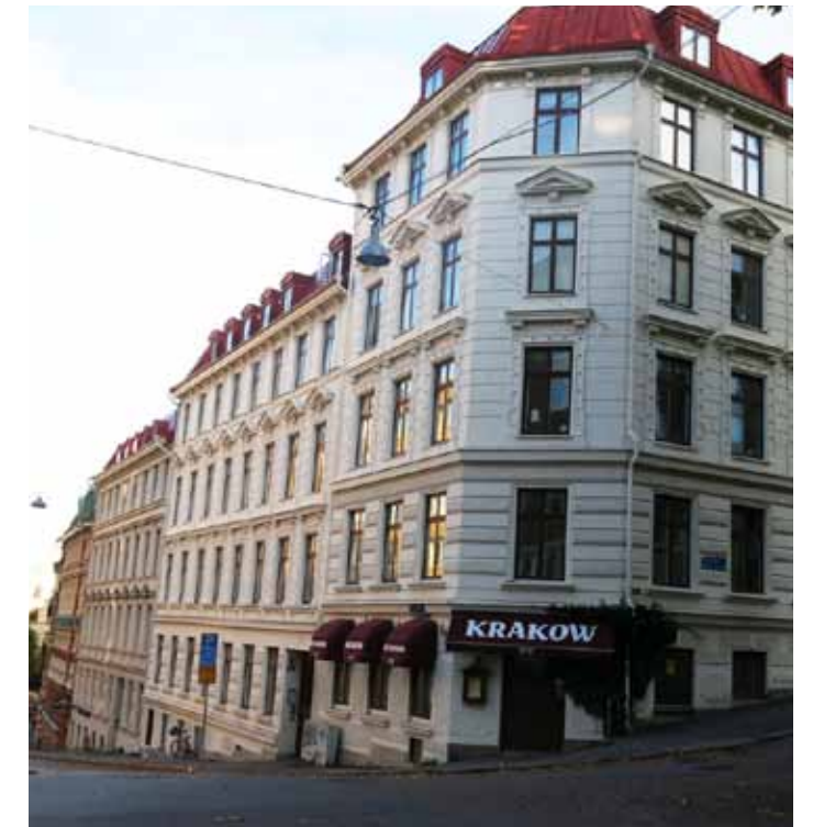
Figur 6. Vasastadens stenhushusbebyggelse från slutet av 1800-talet och början av 1900-talet ingår i bevarandeområdet 10:A.
