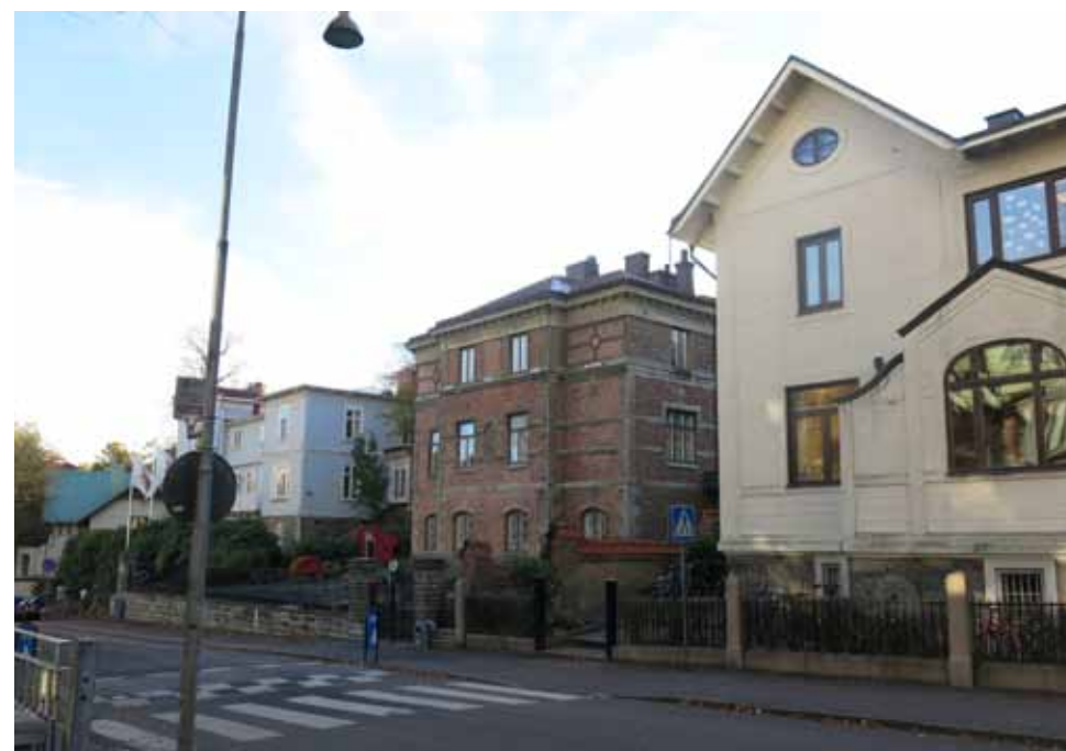
Figur 36. Bebyggelsen i detta gaturum speglar på ett tydligt sätt en högre ståndsmiljö från 1800-talets slut. I dag är användningen ändrad till mer offentlig verksamheter såsom kontor och skola men de bevarade byggnaderna har ändå kvar ett högt upplevelsevärde.
