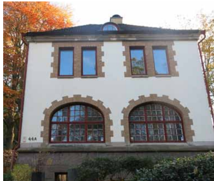
Figur 58. Det före detta pumphuset har tydliga drag av sekelskiftsarkitektur.
