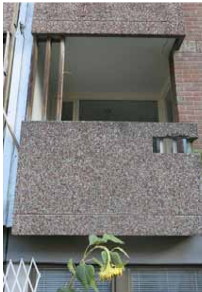
Figur 20. Byggnaden har balkonger med ytskikt av dansk sjösten.
