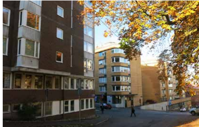
Figur 18. Byggnaden har fönsterband i bottenvåningen
