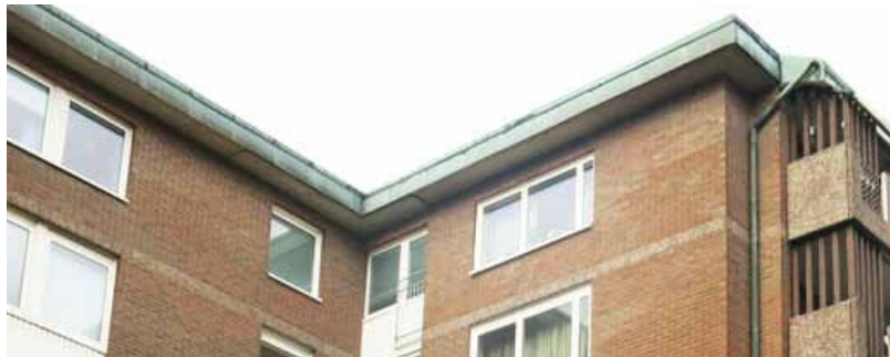
Figur 19. Fasaddetaljer av kopparplåt.
